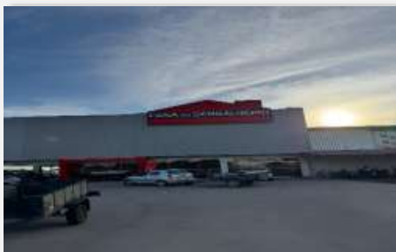
Fachada – Unidade Linhares-ES
